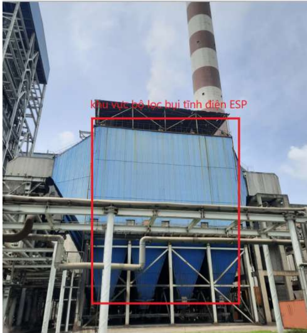
Hình 3.5: Hình ảnh khu vực bộ lọc bụi tĩnh điện ESP
