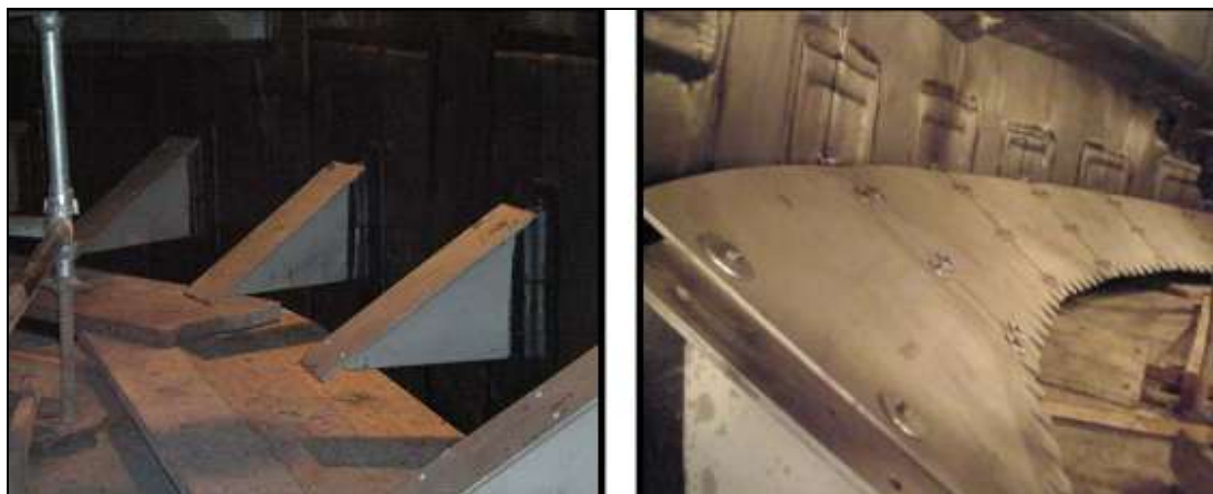
Hình 2.3.6: Lắp đặt các vành chắn tại tổ máy 2 nhà máy BL England
