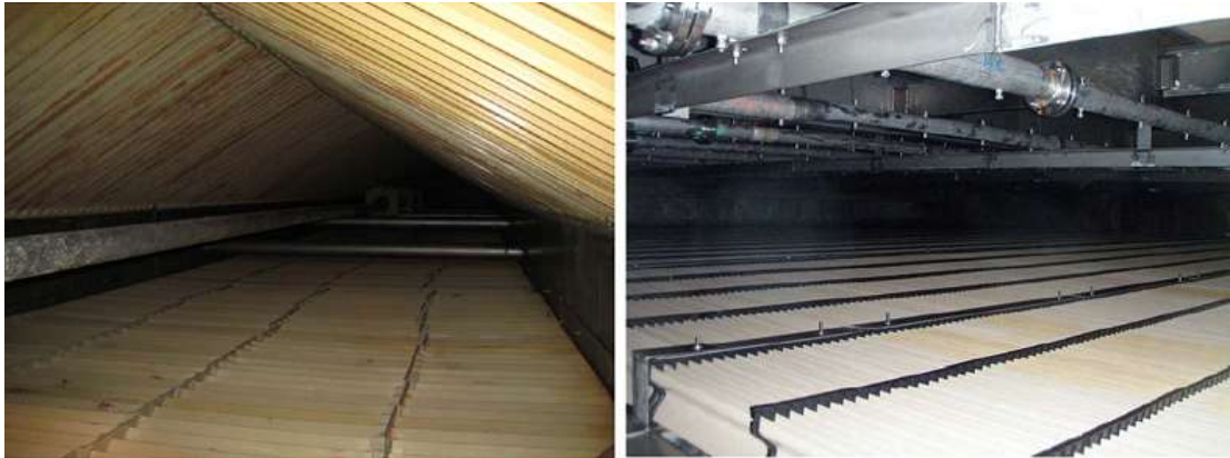
Hình 2.3.13: Nâng cấp vòi phun và khay phân phối khói tại nhà máy điện Fayette
