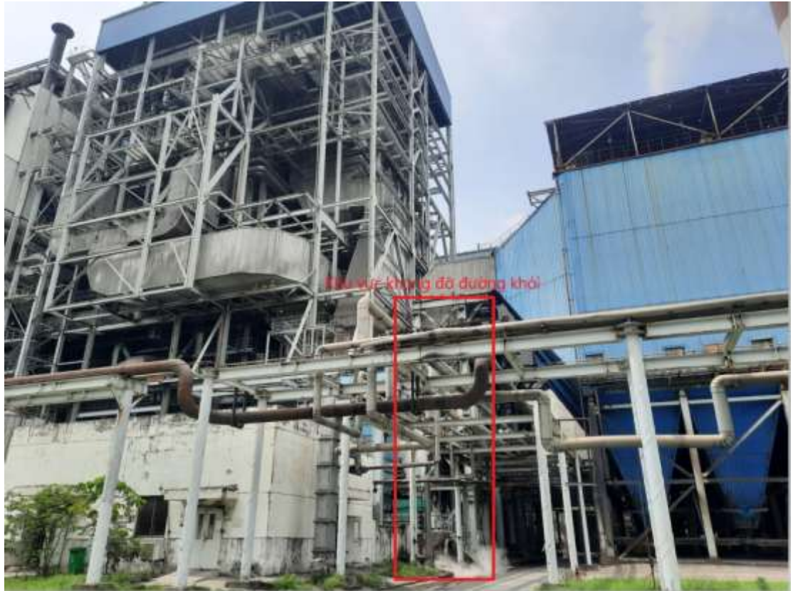
Hình 3.3: Hình ảnh hiện trạng khu vực khung đỡ đường khói
