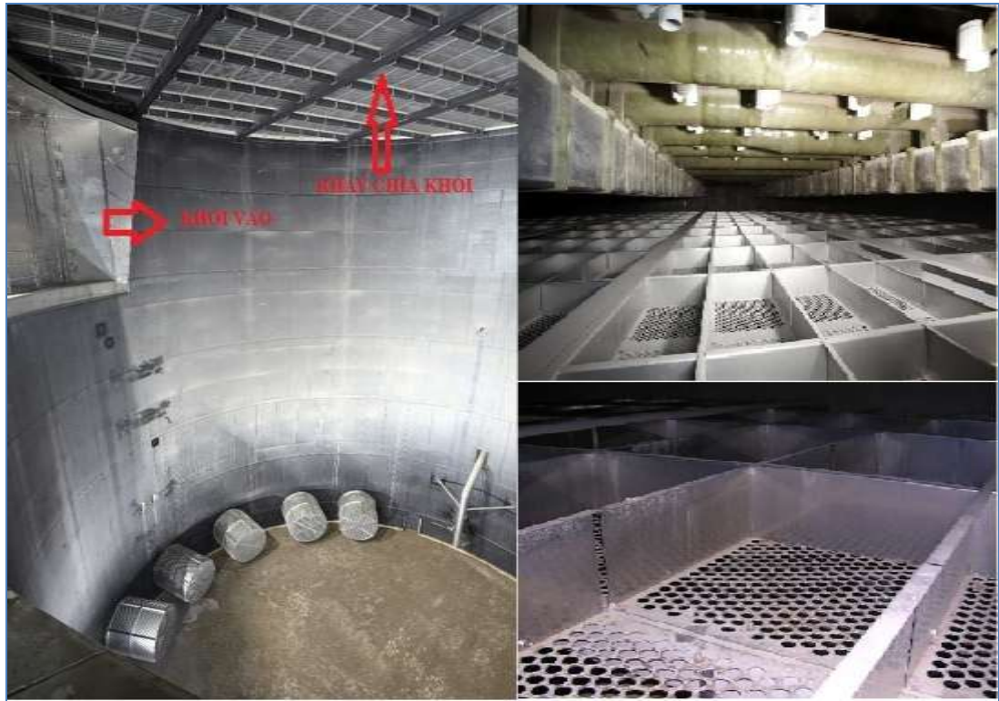
Hình 2.3.9: Vị trí và hình dạng khay chia khói lắp mới
