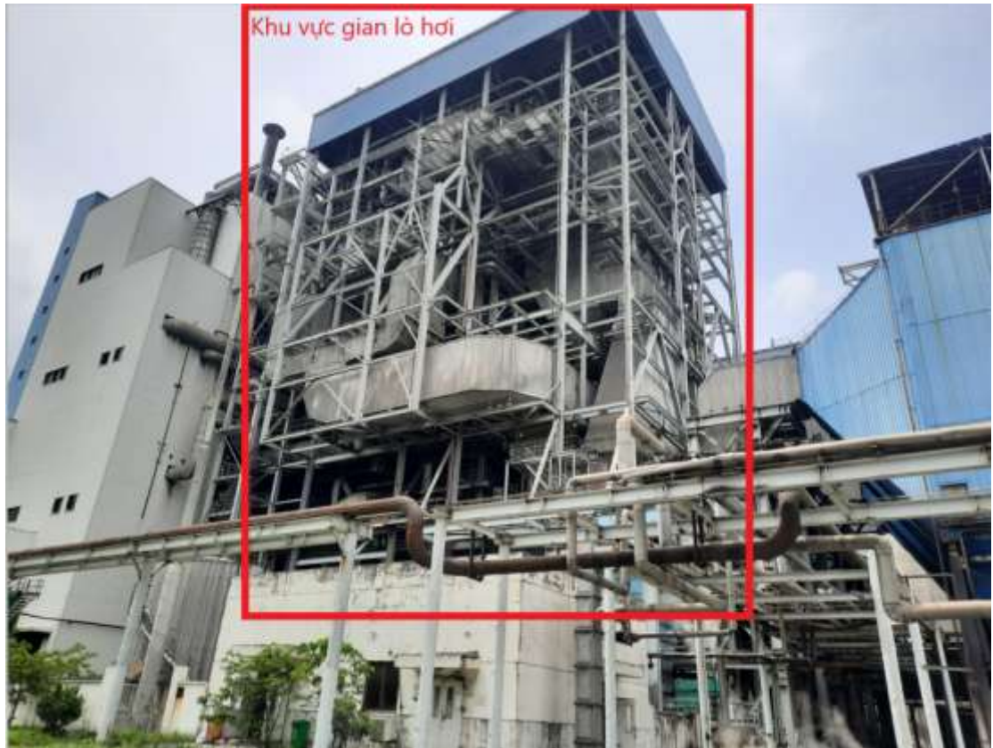
Hình 3.1: Hình ảnh hiện trạng khu vực gian lò hơi
